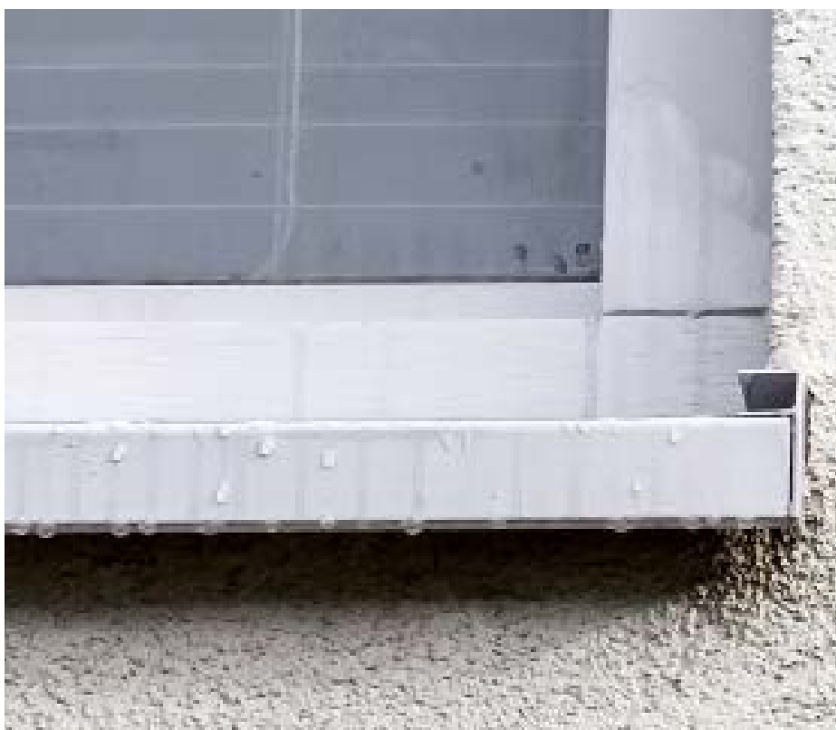
Alleen de onderste delen konden een likje verf gebruiken. Alleen deze delen werden schoongemaakt. Kleurverschil geen bezwaar, komt later wel. De lekstrepen zijn zichtbaar ontstaan door het vuil dat op het oude schilderwerk en de ruit zit.
