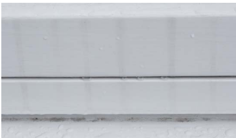
Alleen de onderste delen konden een likje verf gebruiken. Alleen deze delen werden schoongemaakt. Kleurverschil geen bezwaar, komt later wel. De lekstrepen zijn zichtbaar ontstaan door het vuil dat op het oude schilderwerk en de ruit zit.
