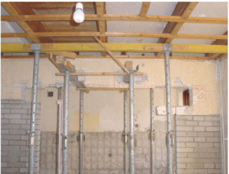
2b. Schroefstempels als tijdelijke opvangconstructie. (bron: Klusservice Uw Rechterhand & Partners B.V.)
