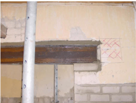
2c. Stalen latei geplaatst, onderkaut en aangeheeld. (bron: Klusservice Uw Rechterhand & Partners B.V.)
