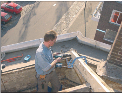
3. Versterken van de bestaande dakconstructie. (bron: Klusservice Uw Rechterhand & Partners B.V.).
