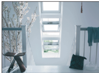
4. Voorbeelden van gekoppelde dakramen. (Bron: Velux BV)
